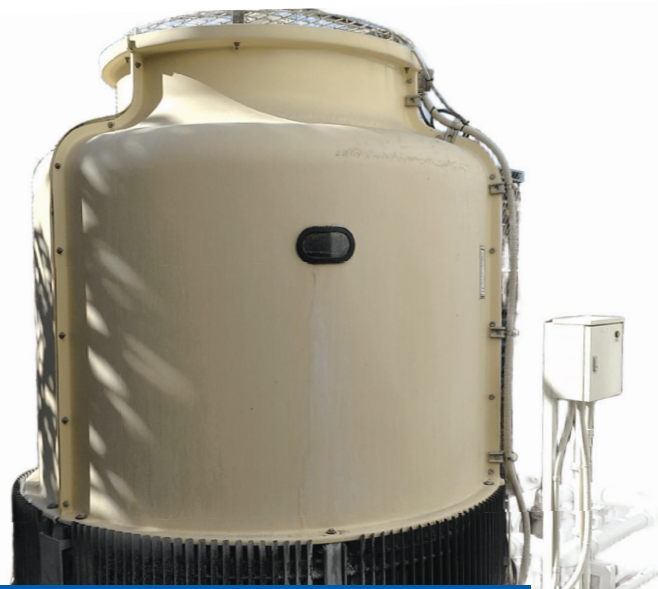
スケールがびっしり付いていた冷却塔（丸型）
