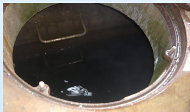
例えば、この場所では循環水があまり流れていないため、ACRの設置場所としては不適です。（水面に波紋が無いことから、水が流れていないことがお分かりいただけると思います）
