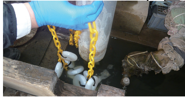
▲タンク例2：この隙間からACRを入れていきます。
