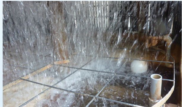
ACR設置1年後の様子。ツテ部スケールが除去されているのが分かります。（白みが無くなっている）
