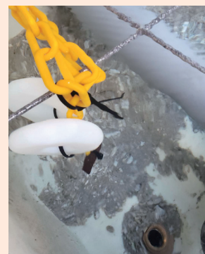
▲剥離したスケールが冷却塔底部に落下し、蓄積した様子
